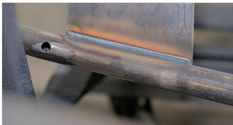
A la estructura básica se sueldan placas delgadas de acero de entre 1,0 y 1,6 milímetros. El proceso de soldadura SpeedCold de Lorch solo aporta la energía necesaria.
