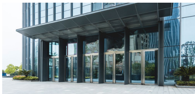
Realizzazione di infissi e facciate
